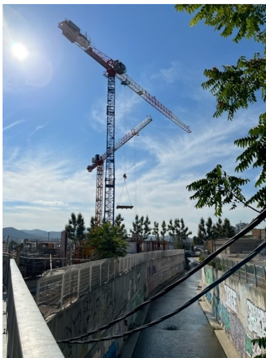
Vue des deux grues du chantier, le long de l'Huveaune
